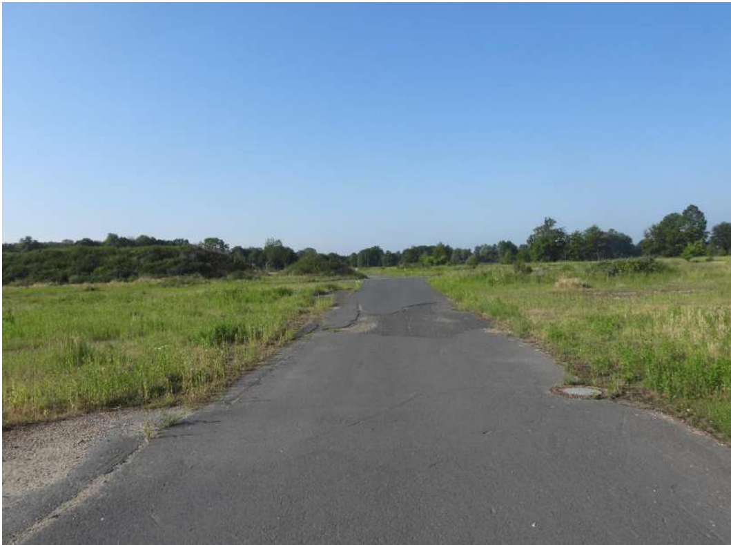
Bild 05: Blick Richtung Süden auf die asphaltierten Teilbereiche sowie Erdaufschüttungen
